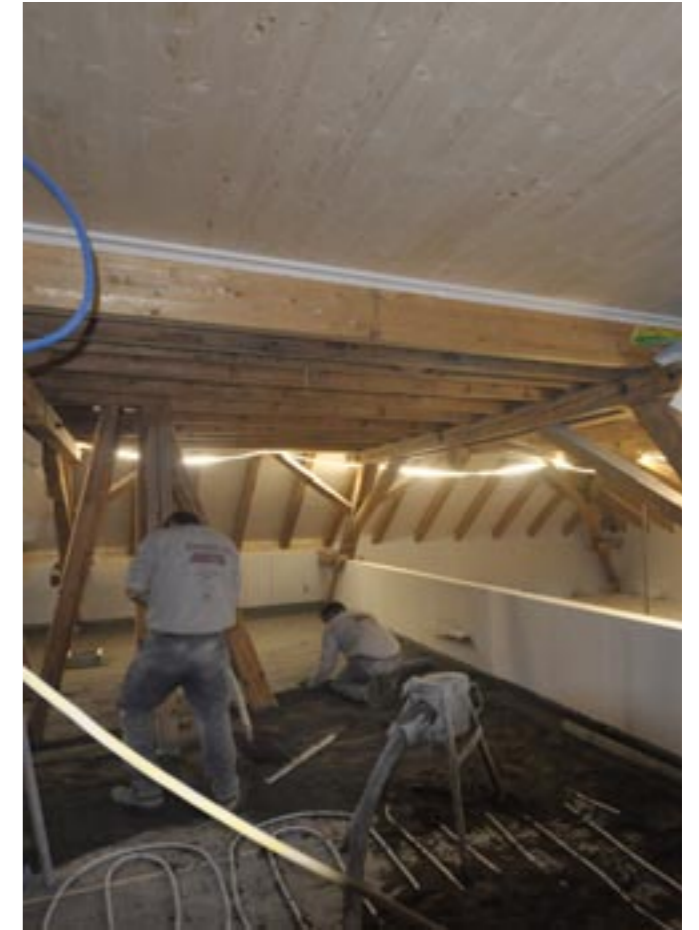
Unterlagsboden und Fussbodenheizung werden eingebaut.
