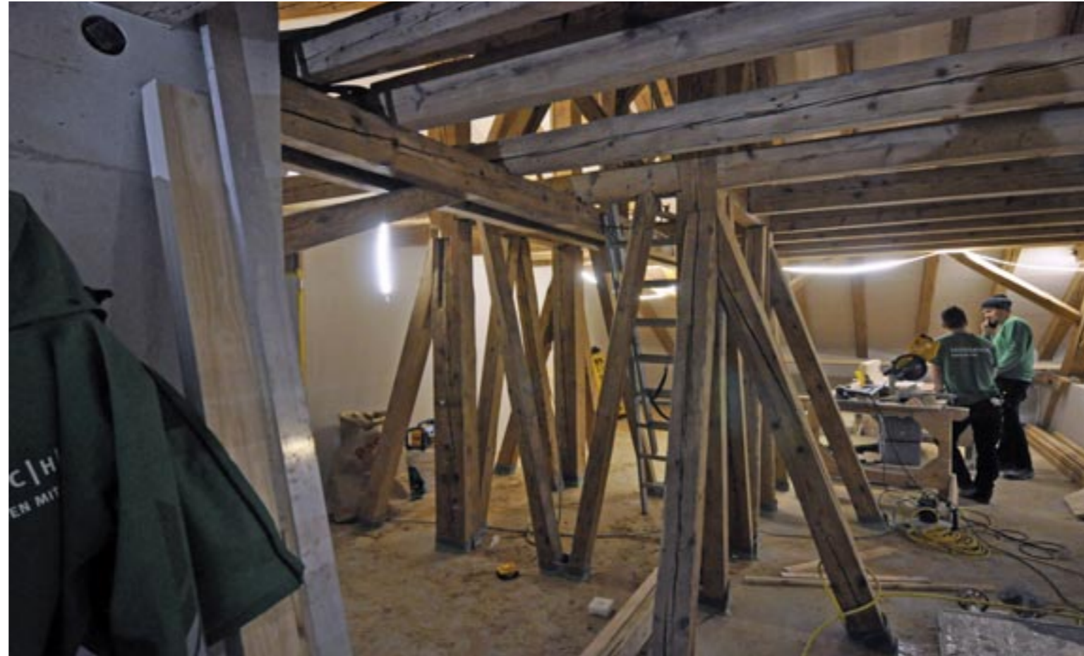
In der Galerie stehen die Balken die den Glockenturm tragen.
