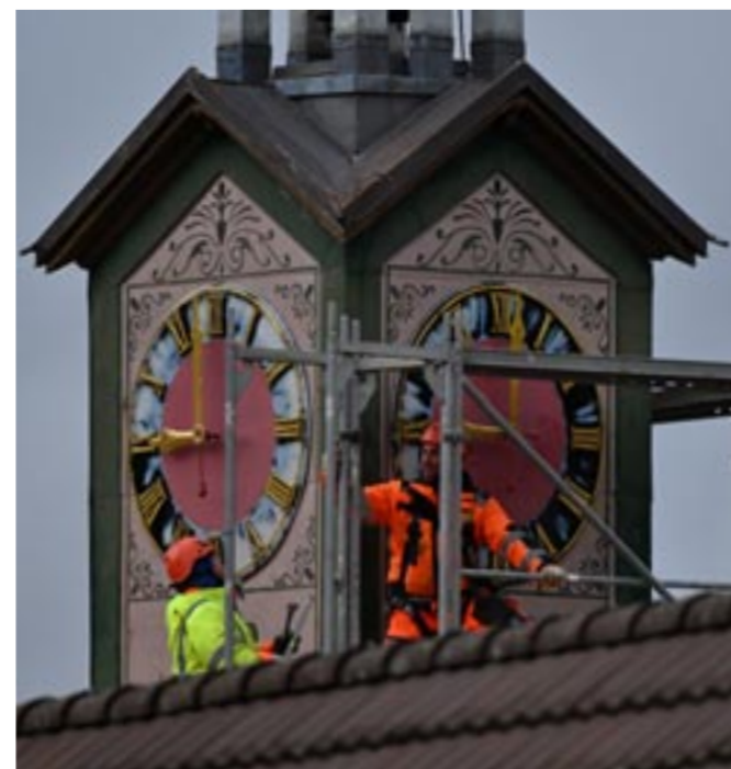
Gerüstarbeiten am Glockenturm.
