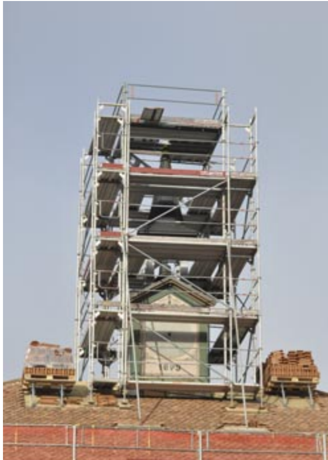
Der Glockenturm wird renoviert.
