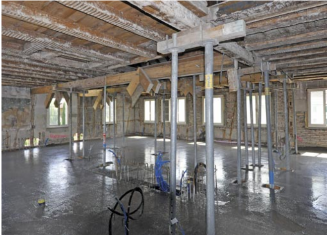
Frisch betonierter Boden.
