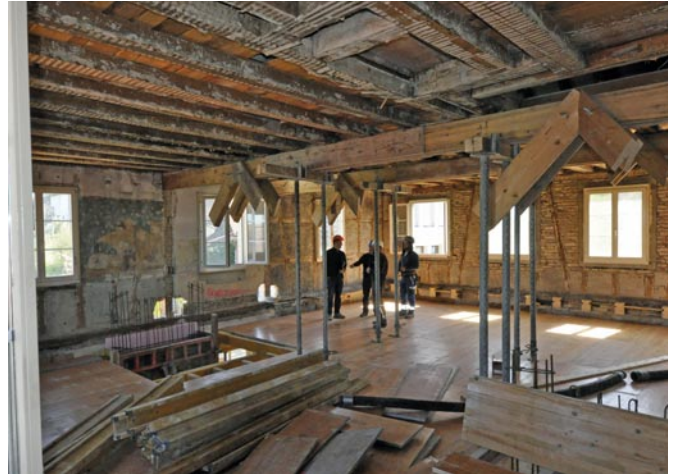
Besprechung auf der Baustelle.
