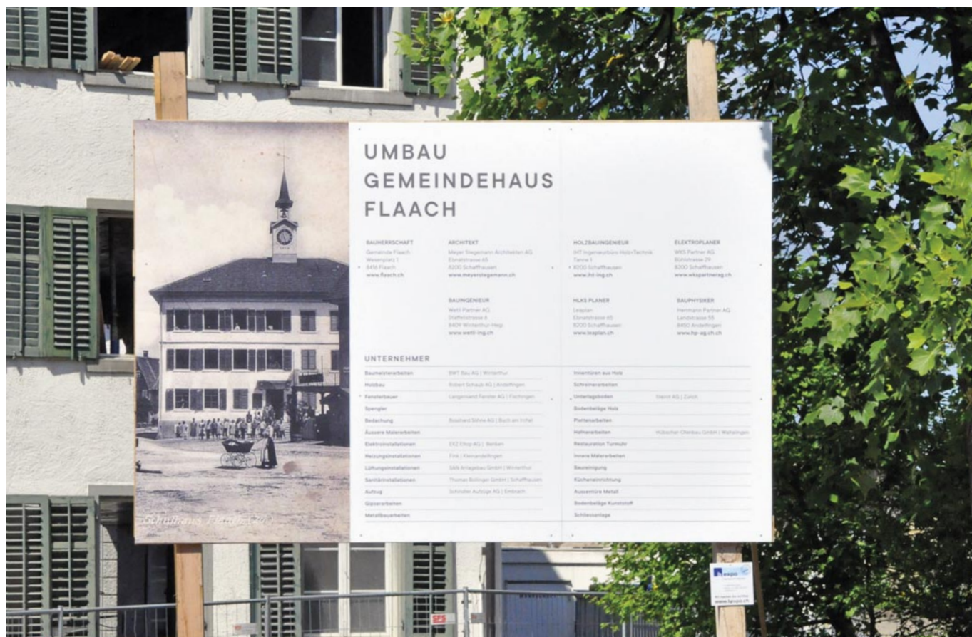
Die Bautafel am Wesenplatz informiert über die am Umbau beteiligten Firmen und Fachkräfte.
