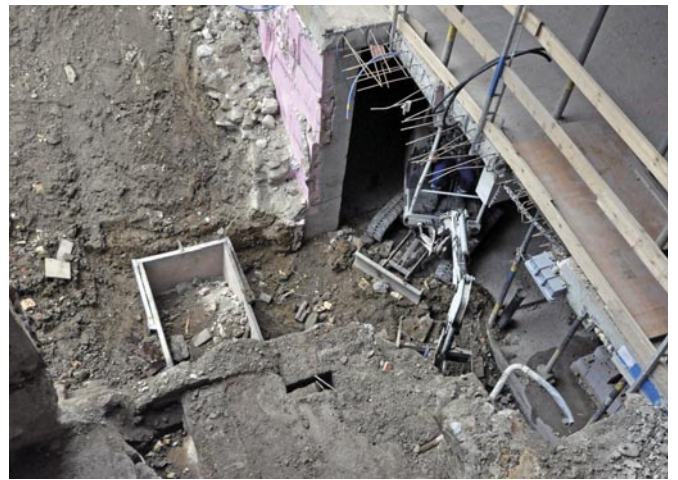
Aushub für den Lift.
