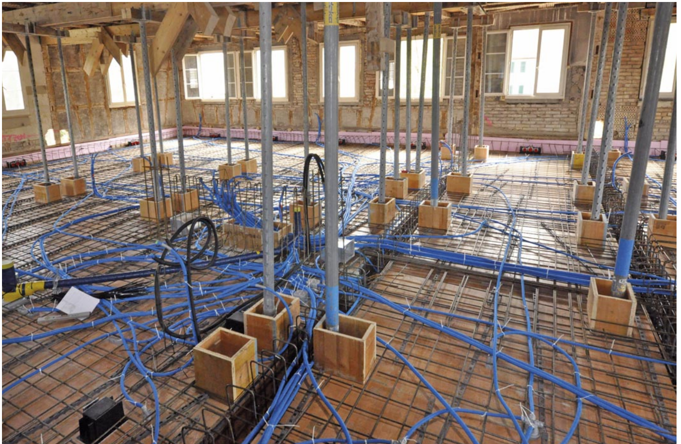
Rohre und Leitungen vor dem Betonieren.
