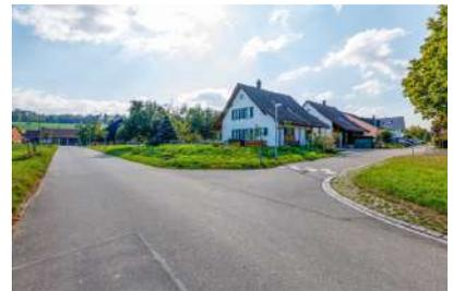
Verengte Einmündung der Schulhausstrasse mit Anrampung. Rasengittersteine und danebenliegend Fahrspuren weisen auf grosse abbiegende Fahrzeuge hin.
