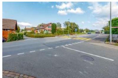
Knoten Hauptstrasse / Mühlebergstrasse / Stichstrasse zur Worbigstrasse bei der Bushaltestelle Flaach, Oberdorf. Das Trottoir auf der Ostseite endet mit dem Ende der Eckausrundung. In der Mitte der Strasse besteht eine erst nach dem Einbiegen sichtbare Sackgasse-Beschilderung ohne Ausnahme, obwohl Fuss- und Veloverkehr weiter kommt.
