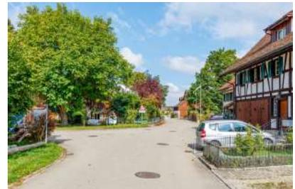
Die mit Eckausrundungsradien von 9,6 m gegen hier und 18 m gegen Norden sehr grosszügige Einmündung der Strehlgasse gegen Norden. Link hinter der Einmündung steht zurückversetzt ein Stall, danach beginnt mit einem Gefahrenschild Kinder das Kindergartenareal.
