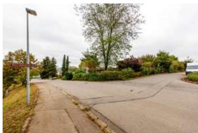
Einmündung der oberen Haldenstrasse in die Tuechstrasse mit 8-m-Radien. Direkt anschliessend an den Einmündungsbereich ragt ein Pferdetransporter in den Strassenraum. Die Strasse weist keine Langsamverkehrsinfrastruktur auf.
