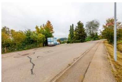
Überdimensionierte Einmündung wie die in die Strasse Halden führen zu abgestellten Fahrzeugen im Knotenbereich.
