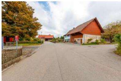
Die Einmündung der Rohnhofstrasse mit Radien von 12 m und 14 m beim Stall in die dort 7 m breite Strasse. Westlich der Einmündung sind es noch 5.5 m.
